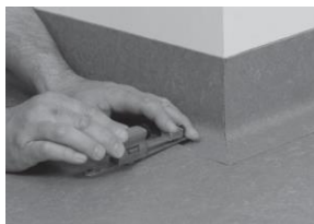
Recorte o revestimento do chão que será colocado Trabalhe na parte superior do rodapé
