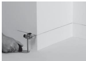
Marcar a altura do revestimento do chão contra a parede com uma linha...
